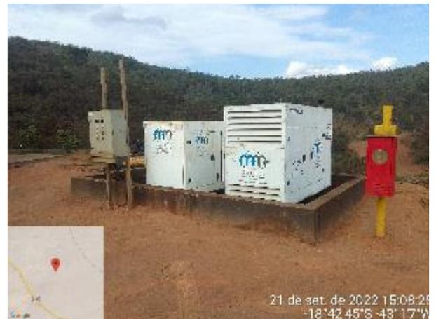
**Figura 54:** Grupo gerador instalado.
