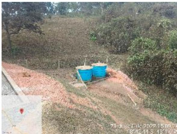
**Figura 55:** Sistema de tratamento de efluentes sanitários instalado próximo ao restaurante da mina.
